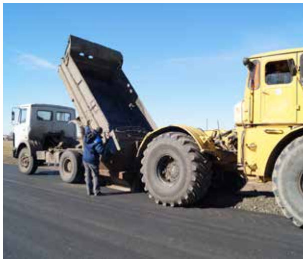
Строительство новой дороги к селу Камыши, 2015 год
