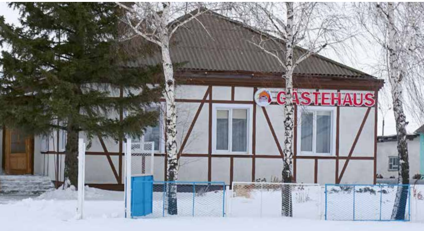
Гостевой дом в селе Шумановка оснащен альтернативными источниками энергии
