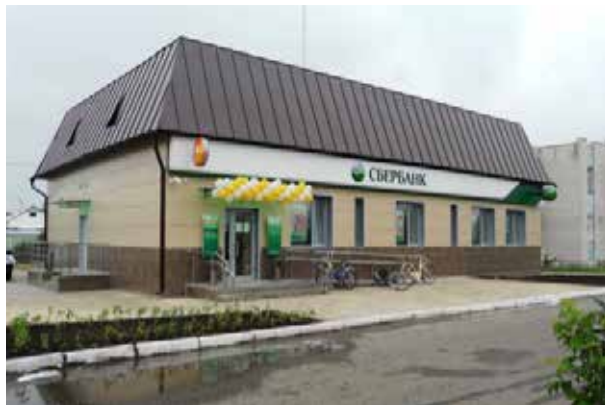
Новое здание Сбербанка в селе Гальбштадт
