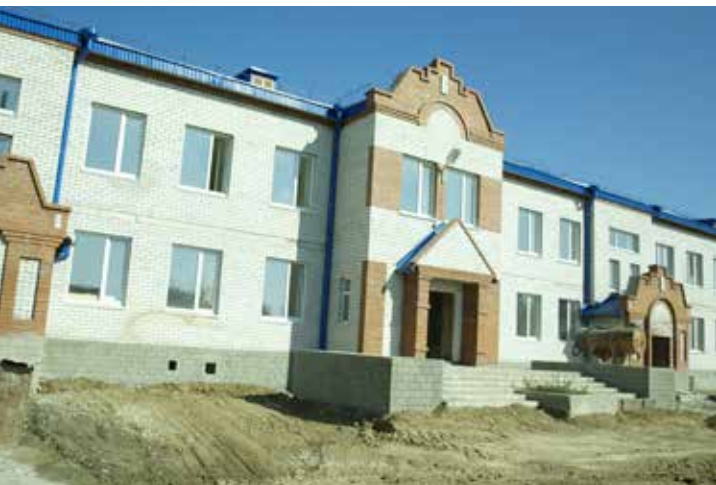
Строительство новой школы в селе Полевое по губернаторской программе 75х75
